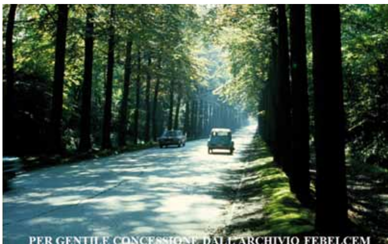
Figura 1 – L'Avenue Lorraine: prima pavimentazione in calcestruzzo a lastre (JPCP) realizzata in Belgio (1925).
