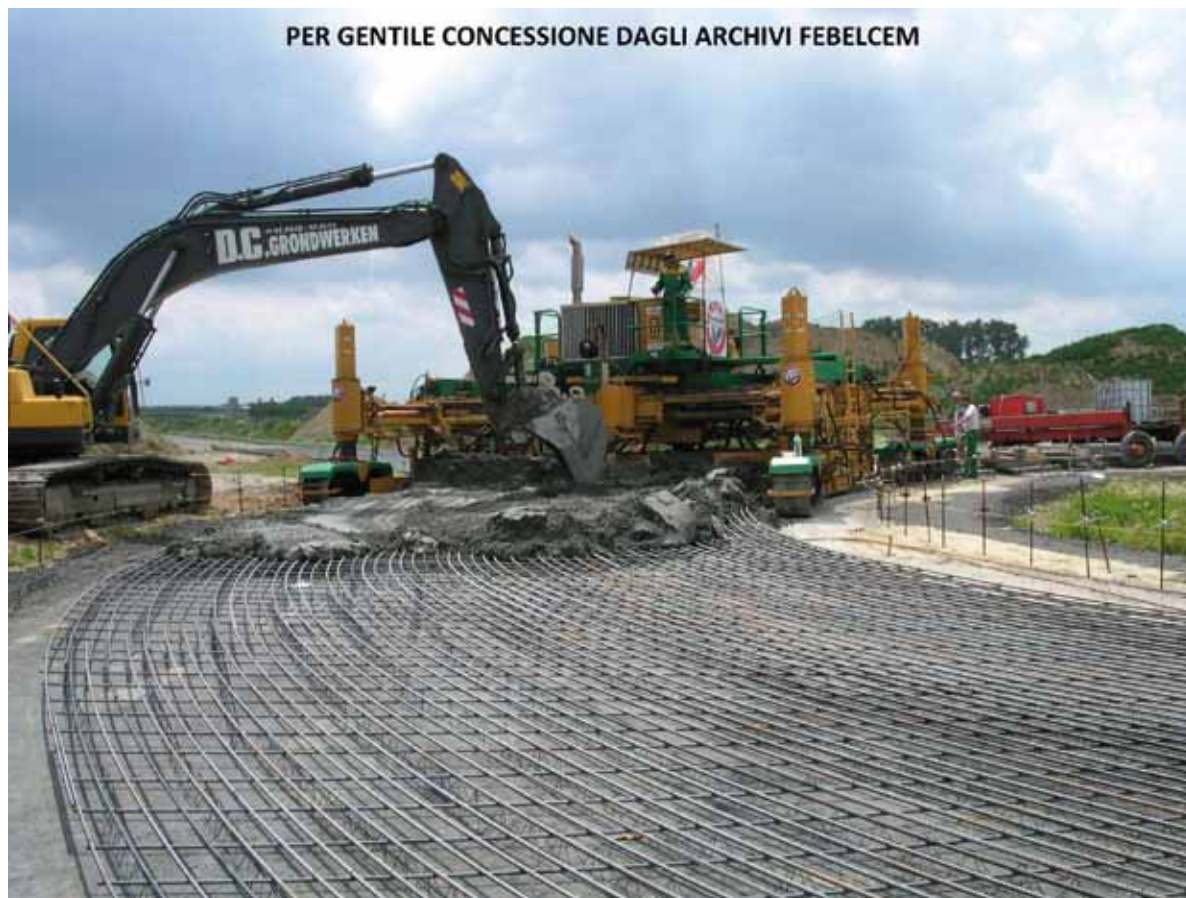
Figura 6 – Esempio di rotonda realizzata con la tecnica di pavimentazione CRCP.
