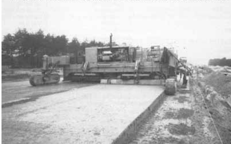
Figura 3 – RN8 - Leuze-en Hainautmentre: primo tratto di pavimentazione in calcestruzzo ad armatura continua (CRCP).
