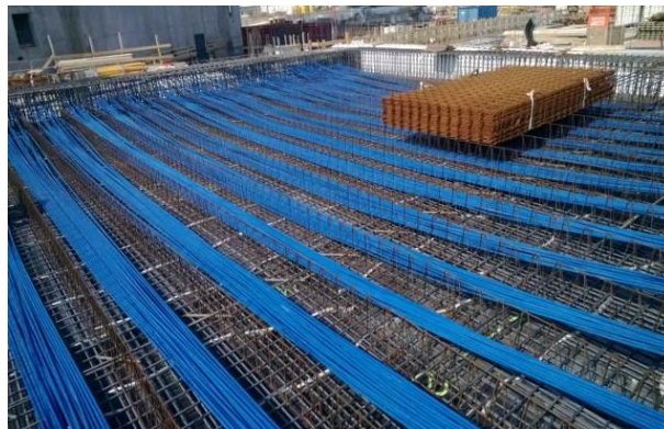
Figura 4- L'armatura di un solaio a cavi post-tesi
