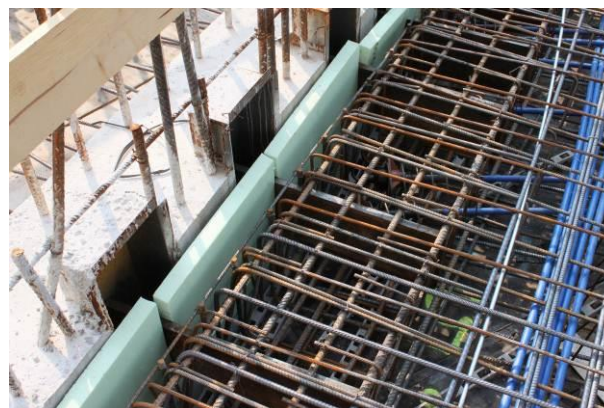
Figura 5- Particolare dei giunti provvisori
