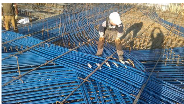
Figura 7- Cavi di post-tensione disposti su tre livelli
