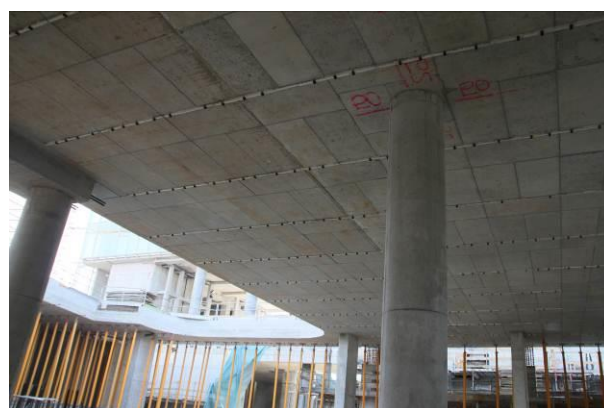
Figura 6- Intradosso finito di un solaio di grande luce
