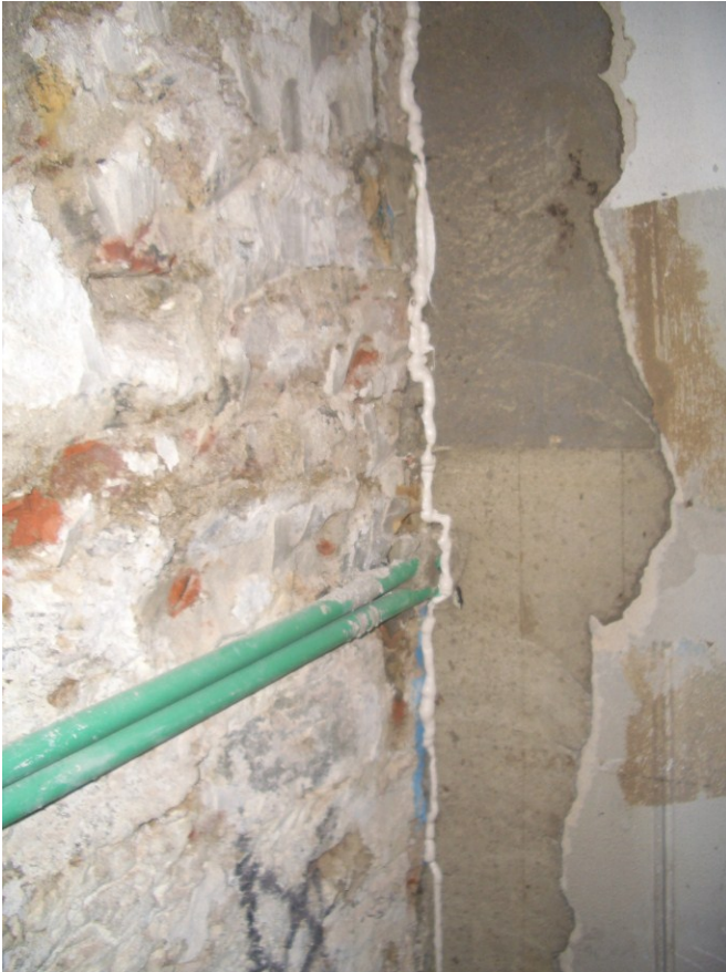
Figura 6 Dettaglio della sigillatura con silicone bentonitico.
