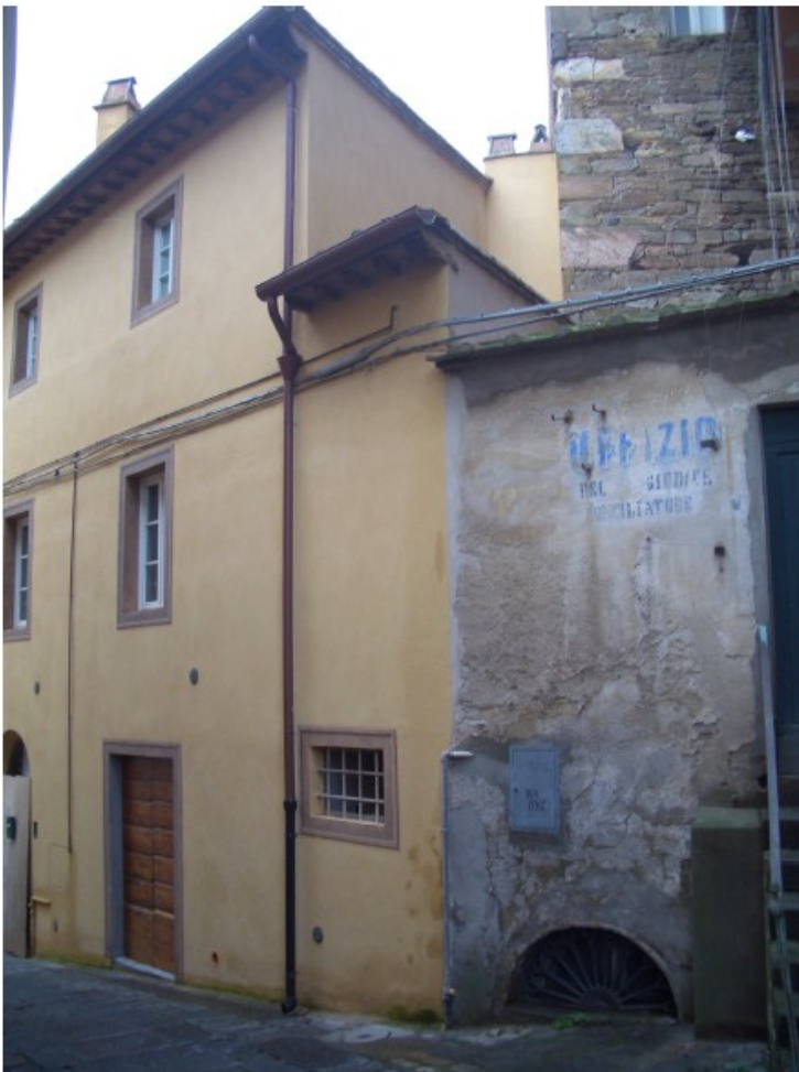
Figura 1 Facciata dell'edificio oggetto di intervento
