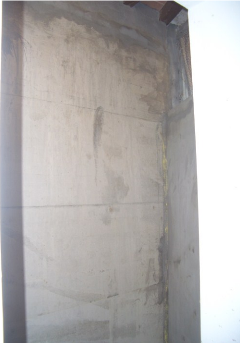
Figura 5 Fasi di stesura del betoncino armato.
