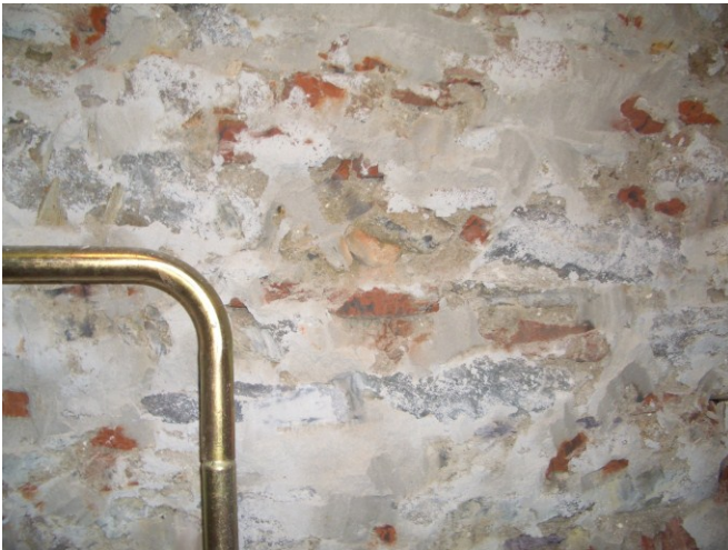
Figura 4 Dettaglio della tessitura muraria
