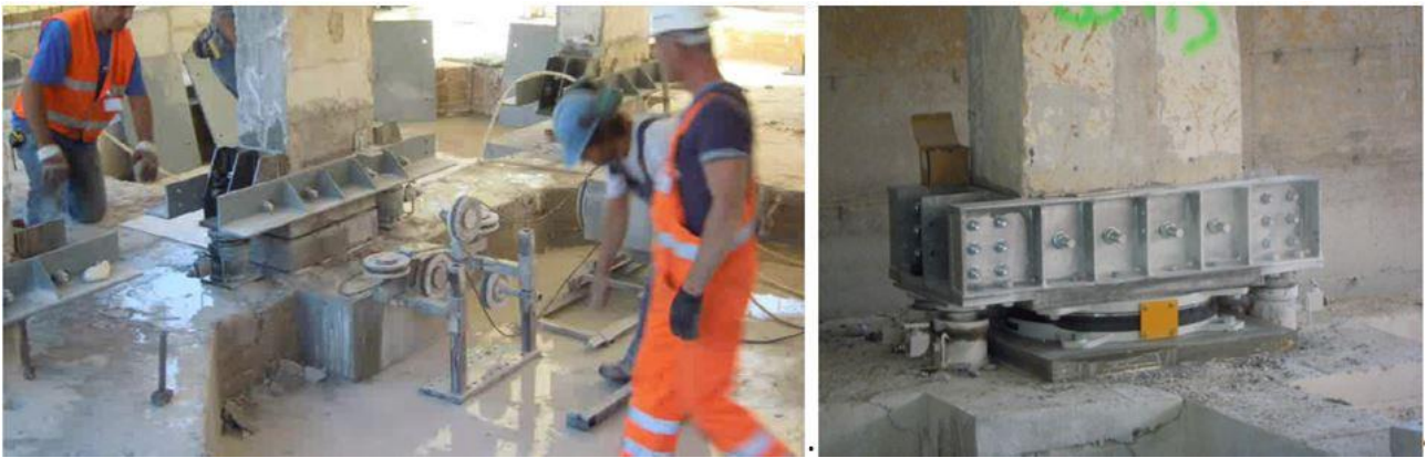
Fig. 2 - Inserimento di un dispositivo di isolamento sismico in una struttura in calcestruzzo armato - immagini, rispettivamente, del taglio del pilastro e subito dopo l'inserimento dell'isolatore.
