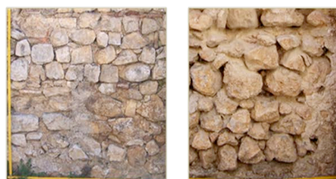
Figura 9. Campioni di murature 1m x 1m rappresentativi dell'edificato storico di San Pio delle Camere.
