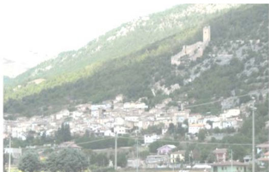
Figura 4. Foto d'insieme del comprensorio edilizio di San Pio delle Camere (AQ).
