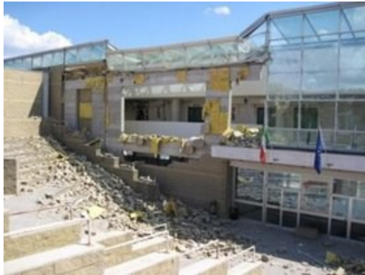
Aquila, Crollo alla Facoltà di Ingegneria
