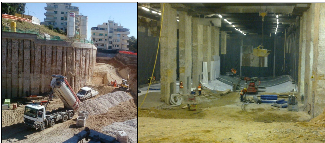
Figura 1: opera di sostegno di monte (a sinistra); ultimo ribasso e getto del solettone di fondo della stazione (a destra)
