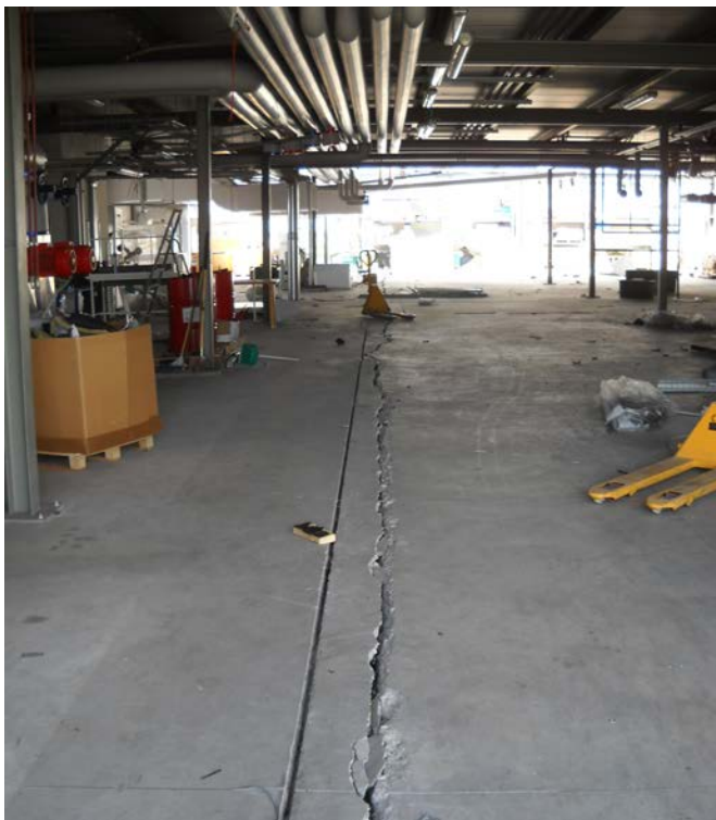
Figura 7. Rottura della soletta d'interpiano.
