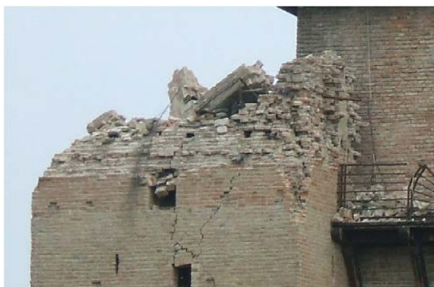
Figura 4. Muratura multistrato in mattoni come emerge dal crollo di una torre monumentale. San Felice sul Panaro (MO).
