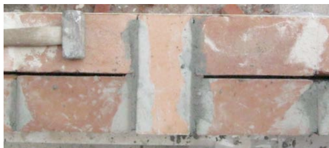
Figura 4. Dettaglio costruttivo di realizzazione del diatono.
