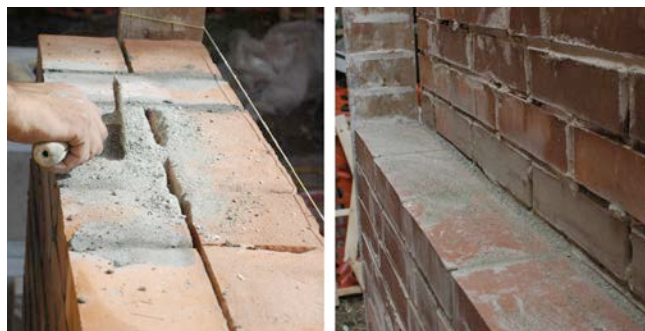
Figura 5. Sottile imbottitura di sabbia tra i paramenti del pannello sia nel caso di collegamento trasversale tra gli stessi che in assenza.
