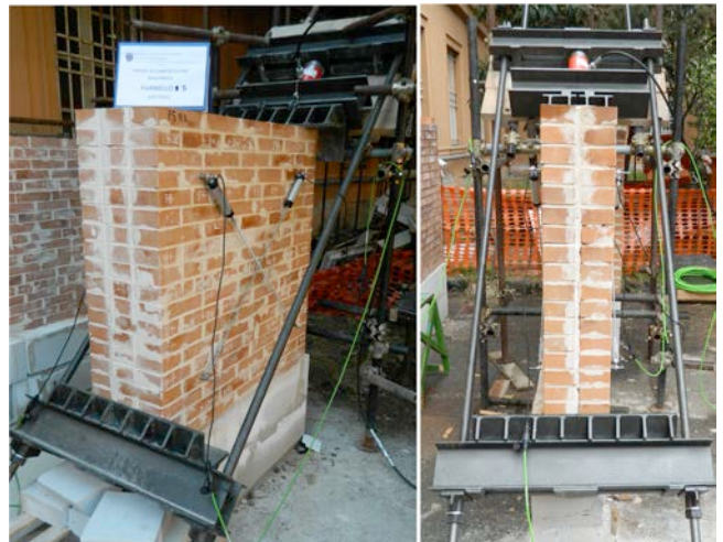
Figura 11. Sistema metallico allestito e pannello strumentato per l'esecuzione della prova.
