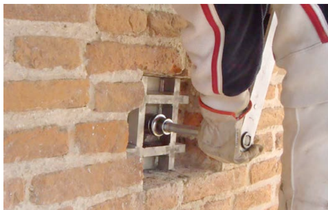
Figura 10. Tiranti: fase di serraggio
