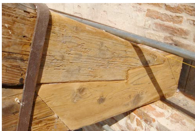
Figura 13. Capriata: ricostruzione della parte marcita.
