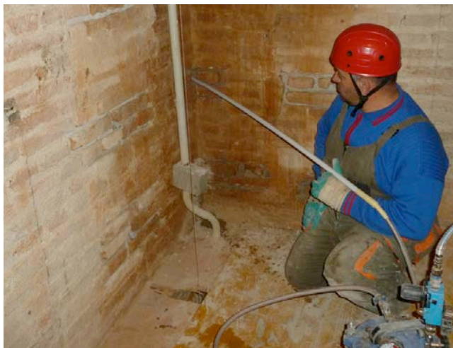
Figura 6. Legatura connettori di ancoraggio: iniezione.
