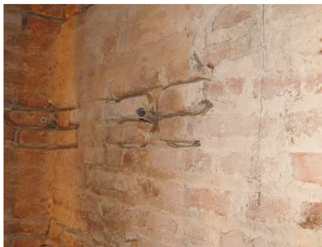
Figura 7. Legatura connettori di ancoraggio: sfiocatura connettori.
