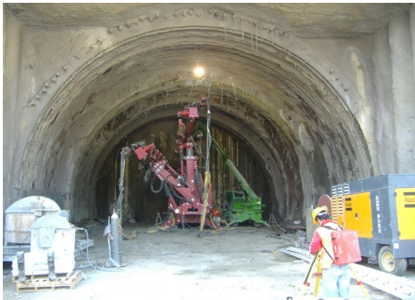
Galleria Novilara oggetto del consolidamento in avanzamento
