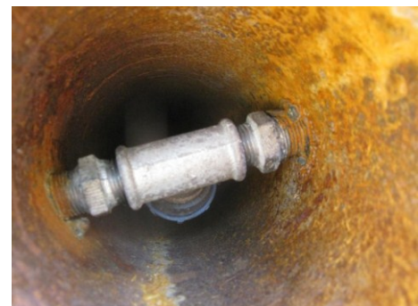
Raccordo a T a fondo foro per l'iniezione della resina MasterRoc MP 355 MR0
