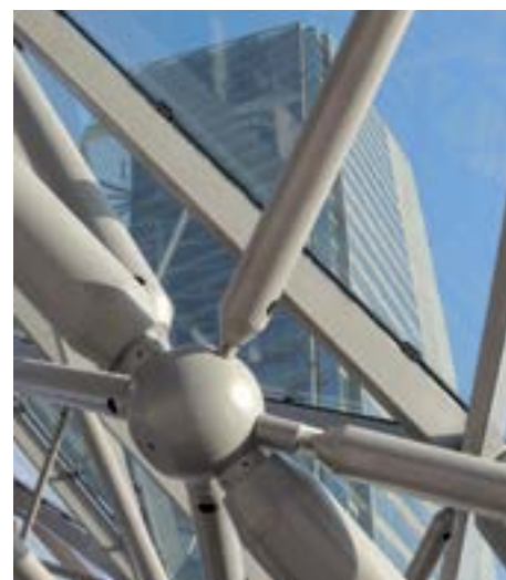
Fig. 12 - Nodo tipico di intradosso
