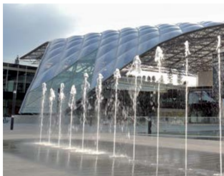
Fig. 1 - Alcune immagini della copertura detta "Vela" ai piedi della torre Unipol a Bologna
