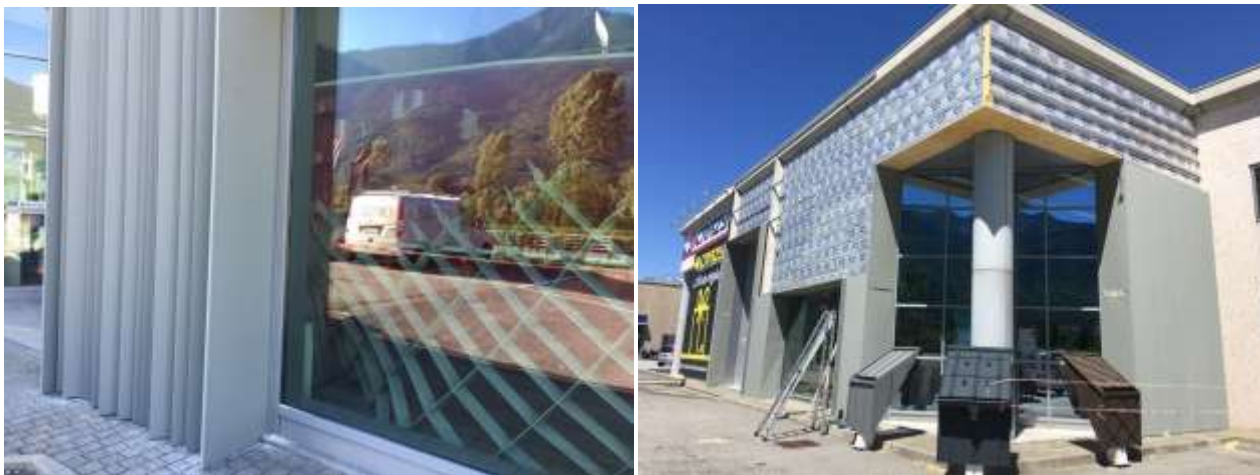
Le fasi della posa di ISOTEC PARETE sull'edificio esistente e del rivestimento metallico sulla facciata.
