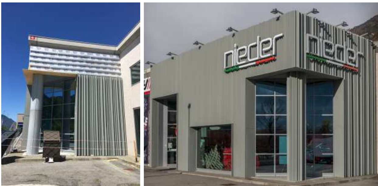
La sede della Nieder cambia volto: il rivestimento metallico personalizzato sulla facciata.
