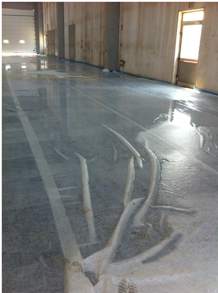
Fase di maturazione mediante geotessuto mantenuto costantemente umido
