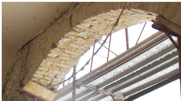
Arco prima dell'intervento: rimozione completa di intonaci o rivestimenti esistenti.
