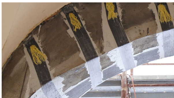
Particolare delle fasciature a "U" e connettori aramidici ARMOGRIP.
