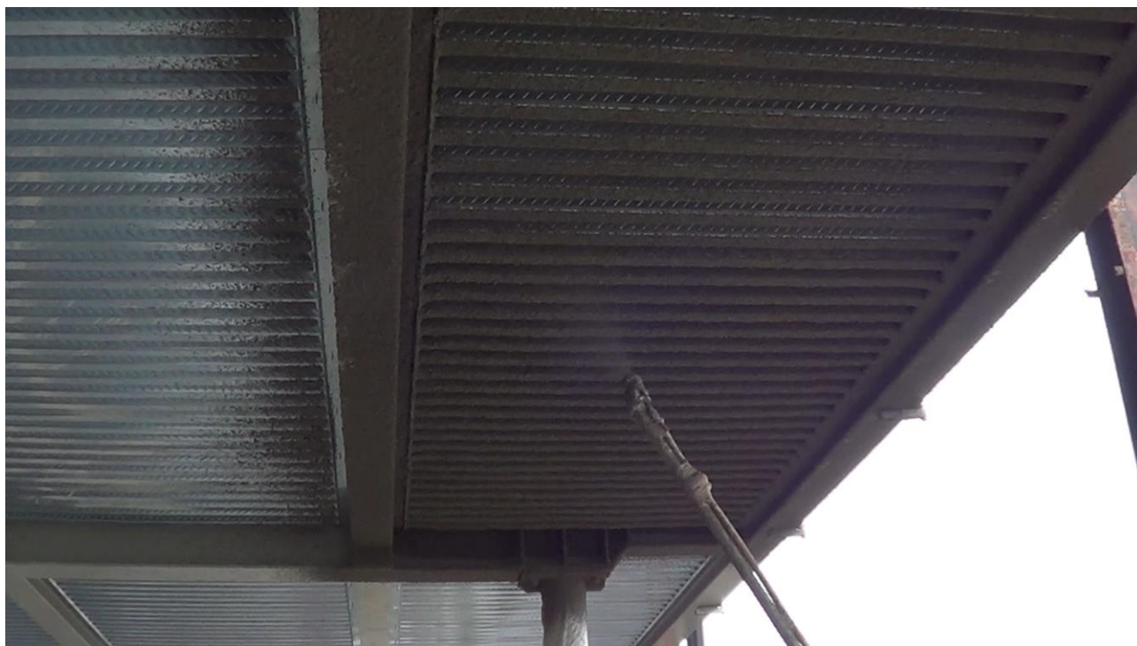
Figura 2 “Applicazione meccanica a spruzzo su solaio in lamiera grecata e travi”
