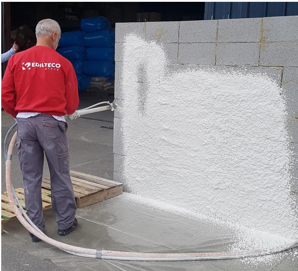
Figura 3 “Prova di spruzzo su muratura a blocchi”
