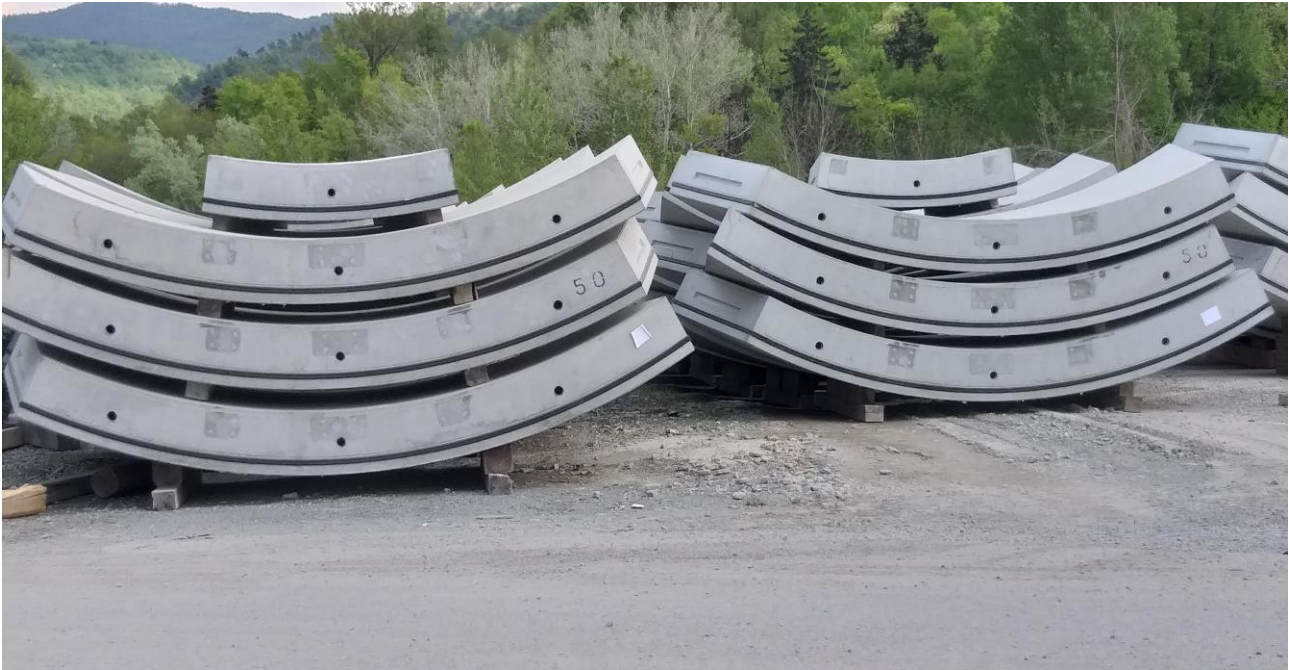
Figura 3. Fase di stoccaggio di conci prefabbricati
