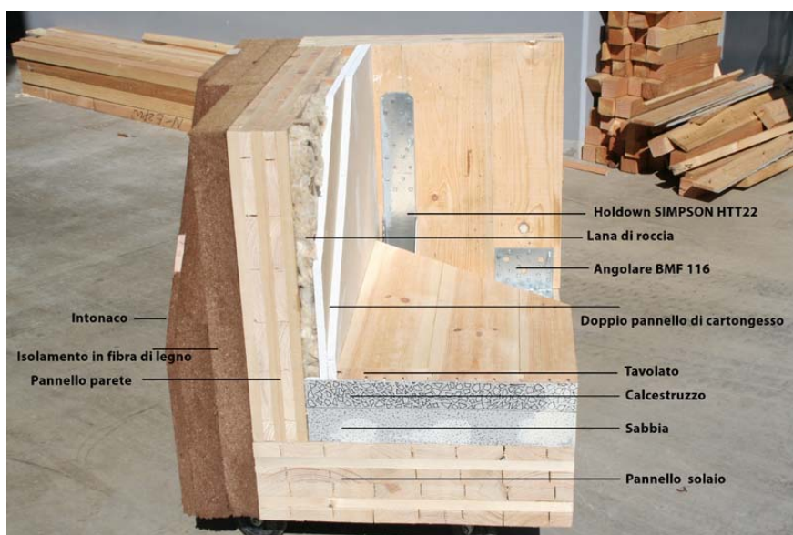
Figura 2 - Particolare costruttivo dei materiali generalmente utilizzati per completare il pacchetto parete esterna e solaio
