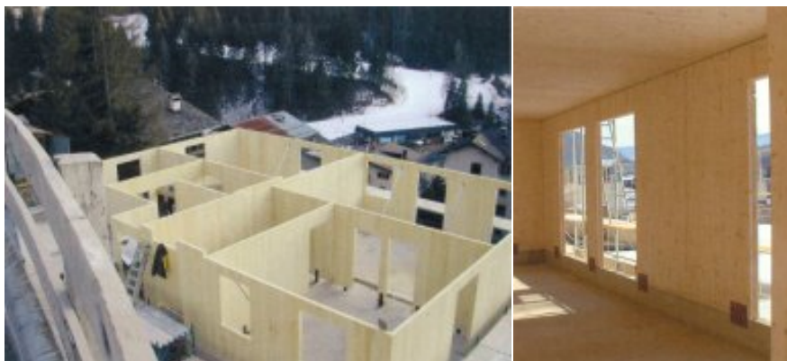
Figura 1 - Sistema di costruzione a pannelli multistrato.
