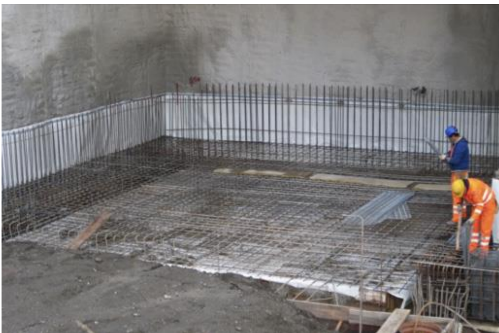
Figura 9. Fondo scavo posa impermeabilizzazione
