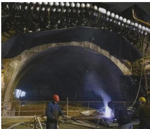
Figura 8. Camerone di scavalco con calotta completata con congelamento attivo
