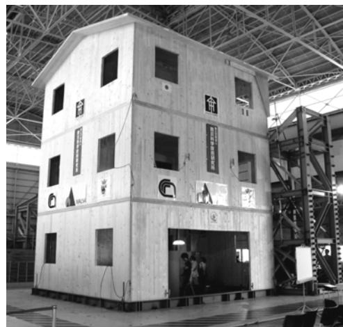
Figura 2. Edificio SOFIE di tre piani per test sismico a Tsukuba
