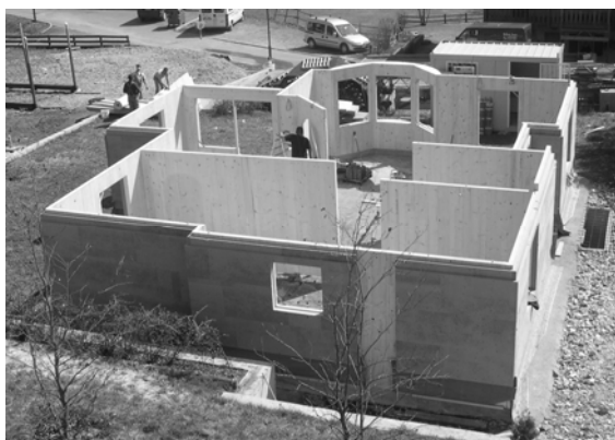
Figura 1. Tipica costruzione X-lam (Foto Rasom)
