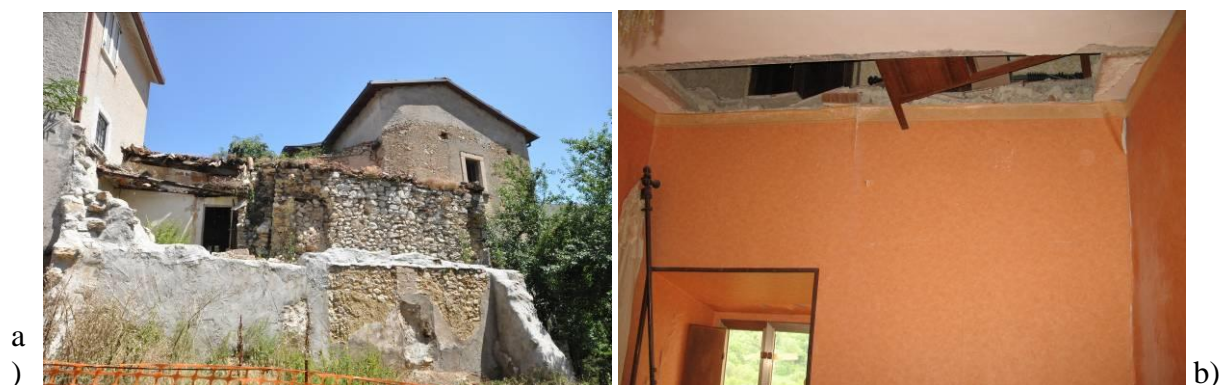
Figura 3. Danni osservati: a) Danni verso via San Giorgio; b) Crollo di tavelloni di solaio. Per la posizione dei punti di vista vedi Figura .
