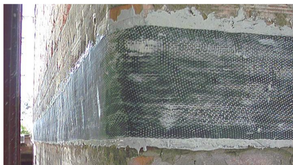
Cerchiatura con tessuti unidirezionali in fibra di carbonio ARMOSHIELD C.
