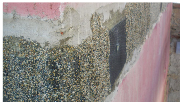
Particolare dello spolvero finale con sabbia al quarzo per favorire la successiva posa dell'intonaco.
